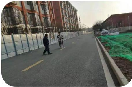
5. 完成了楼位、开挖边线、打桩位置放线工作；
