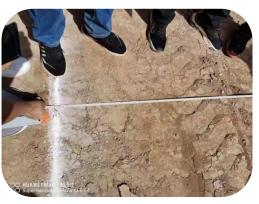
经过现场勘验,大家一致认为:基坑周围土质均匀、结构密实;基坑西侧民房、东侧医务室无异常情况;深基坑支护完整、安全措施到位、基础周边无堆载;基坑变形监测无异常;基坑位置、放坡、标高符合图纸设计要求。同意开展下一步的基坑回填作业。
