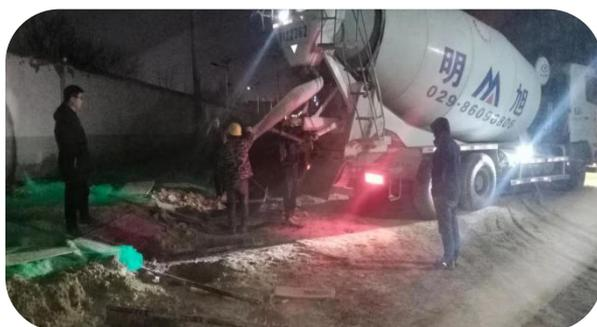
在施工现场南侧10千伏高压线尚未落地的不利情况下，为确保施工安全，我们要求施工单位科学合理调整施工技术方案，高压线下采用机械洛阳铲钻孔，安全区域采用旋挖钻机钻孔，这样极大地提高了施工效率，也保证了施工安全。仅用15天时间，在2021年春节前极其宝贵的时间节点内顺利完成了129根桩的成孔、钢筋笼制作、吊放钢筋笼、混凝土浇筑等作业，为3月15日禁土令解除后即将开始的基坑开挖作业打下良好基础。
