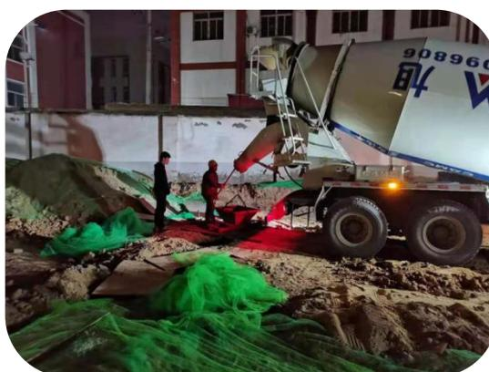
基坑“护坡桩”工程是学生公寓楼建设工程的控制性工程。施工总承包单位招标确定后，我们即统筹协调完成了专业分包基坑支护工程施工单位的公开招标，并督促施工单位于2021年1月25日进场，2月8日完工并平整场地、挂网覆盖，历时15天。施工期间共成桩129根，桩孔径70公分，其中桩长10.45米的桩40根、11.20米的桩89根。使用钢筋69吨、商业混凝土569.5方。“护坡桩”工程顺利完工为节后全面开工赢得了一个多月时间，对于整个项目顺利推进、按期交付使用至关重要。
